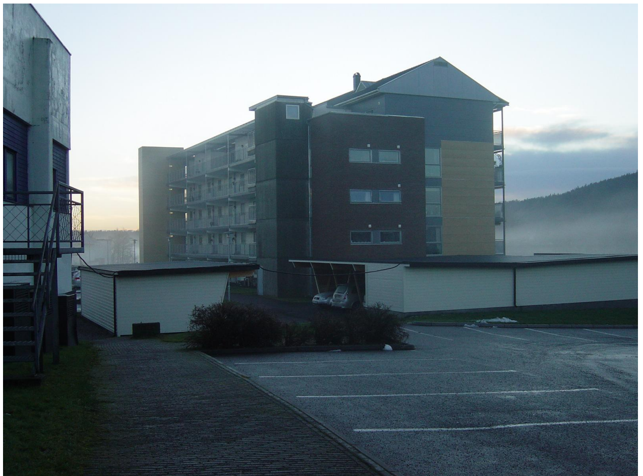
Boligbebyggelsen sett fra kjøpesenteret.
