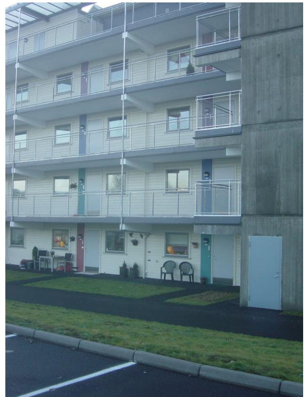
Inngangsfasade med svalganger.
